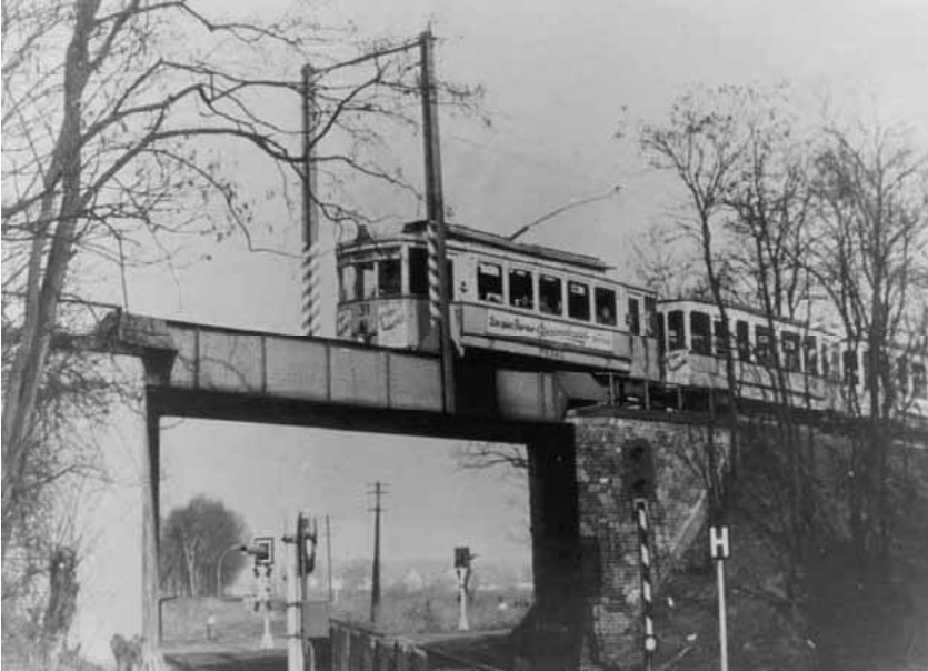
Fahrt der Bahn über die Brücke
